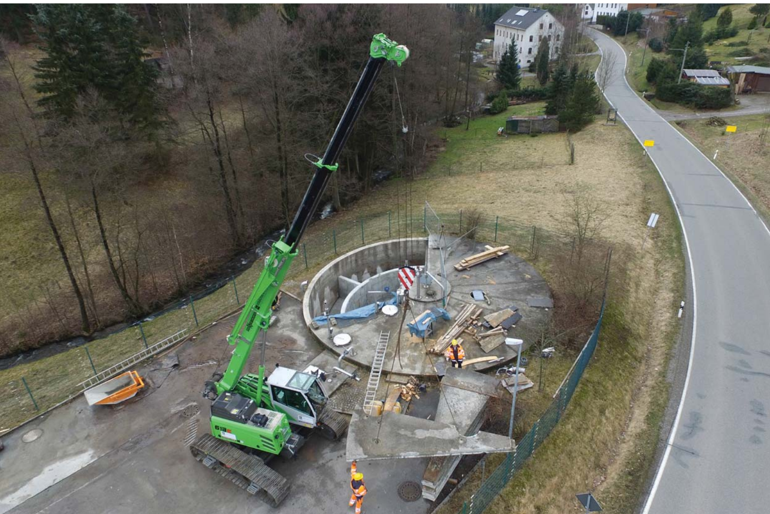
Le châssis sur chenilles SENNEBOGEN 613 E déplace et lève des charges lors de la construction d'une station d'épuration provisoire en Allemagne.
